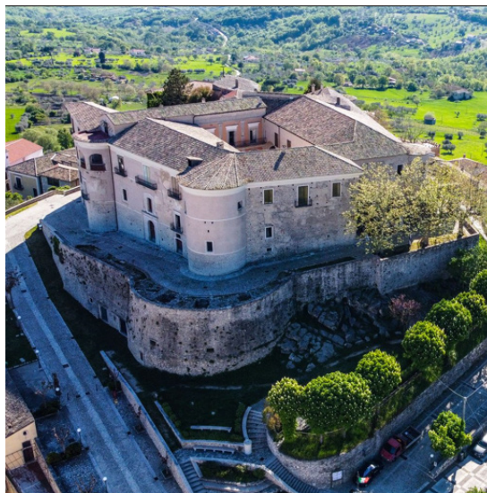
Fig. 2 – Foto area del Maniero
