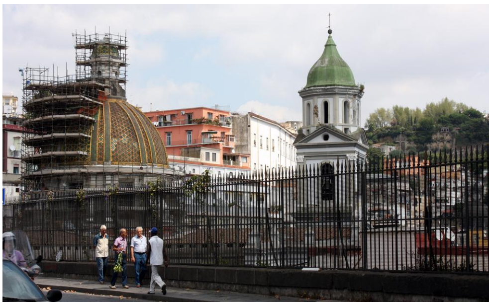
Fig. 3 – La cupola della basilica di S. Maria della Sanità durante i lavori di restauro
