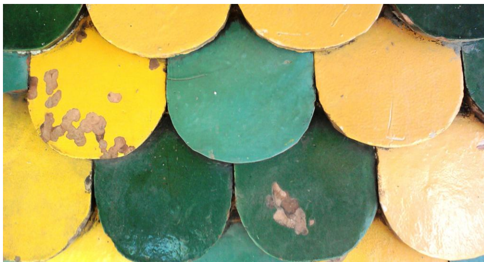
Fig. 4 – Particolare degli embrici maiolicati della cupola di S. Maria della Sanità con una varietà di coloriture svelate dalle puliture durante i restauri
