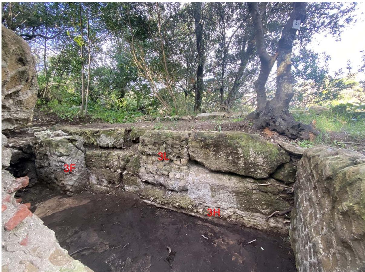
Fig. 13 - Paramenti interni del muro perimetrale Ovest con i tre momenti costruttivi, da Sud-Est. Si evidenziano, in particolare, parte del muro Ovest prima citato (3F); la fondazione del muro realizzato in cassaforma lignea (3H) e la tamponatura della porta con il rimpiego di *cubilia* (3L)
