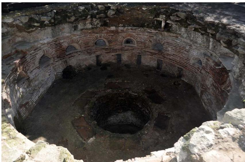
Fig. 3 - Visione da Ovest del sistema di riscaldamento di terza fase, in cui sono visibili il muro in opera laterizia con relativo sistema di doppio livello di archetti e feritoie rettangolari in basso a livello del piano pavimentale dell'ipocausto. Al centro il pozzo. In alto verso Est gli strati di obliterazione dell'ambiente riscaldato durante la quarta fase
