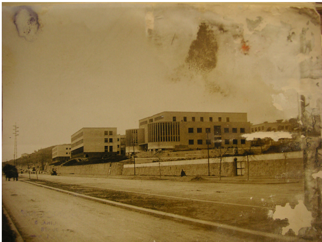
Fig. 11: Il Collegio visto dalla strada che, provenendo dalla Mostra, porta a Bagnoli. Si intravedono il muro perimetrale della Scuola di Equitazione, anch'essa in costruzione, il palazzo della direzione e le palazzine dei dormitori maschili. Foto storica, 1940, Archivio Banco di Napoli.
