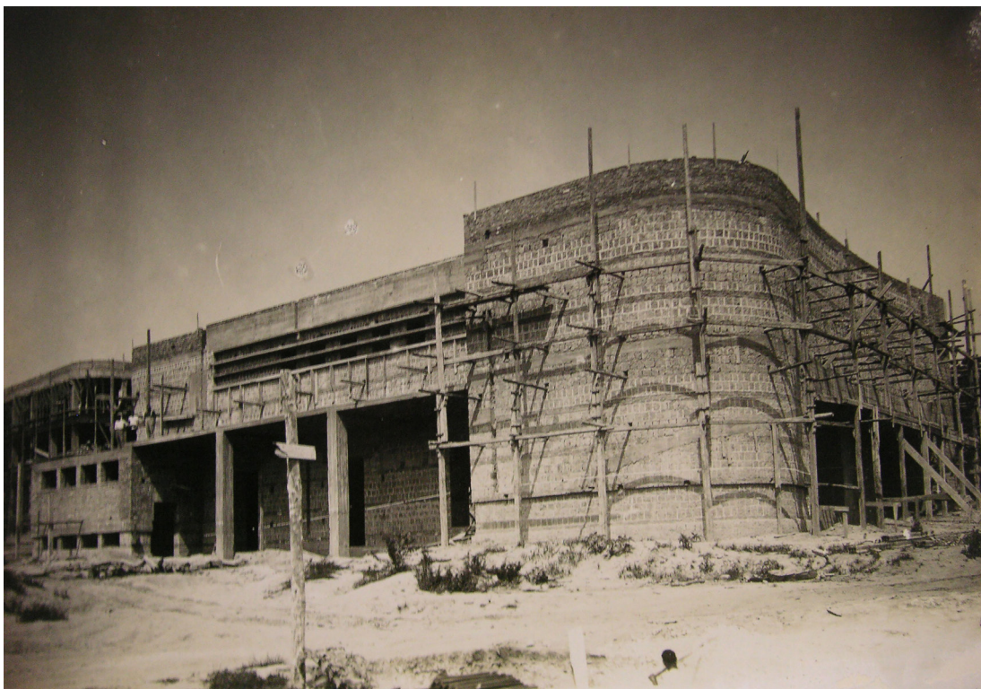
Fig. 13: Foto del cantiere del teatro. Foto storica, 1939, Archivio Banco di Napoli.
