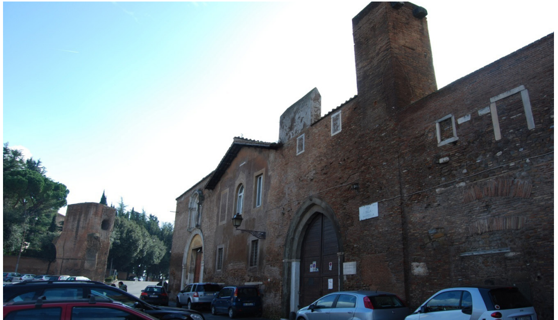
Fig. 10: Roma. Complesso di San Tommaso in Formis. Foto attuale del prospetto su piazza della Navicella (foto dell'autore, 2013).
