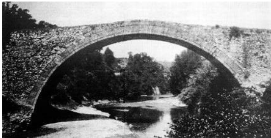
Fig. 3: Il Ponte di Luogosano prima della ricostruzione (da Luogosano ieri e oggi 2006).
