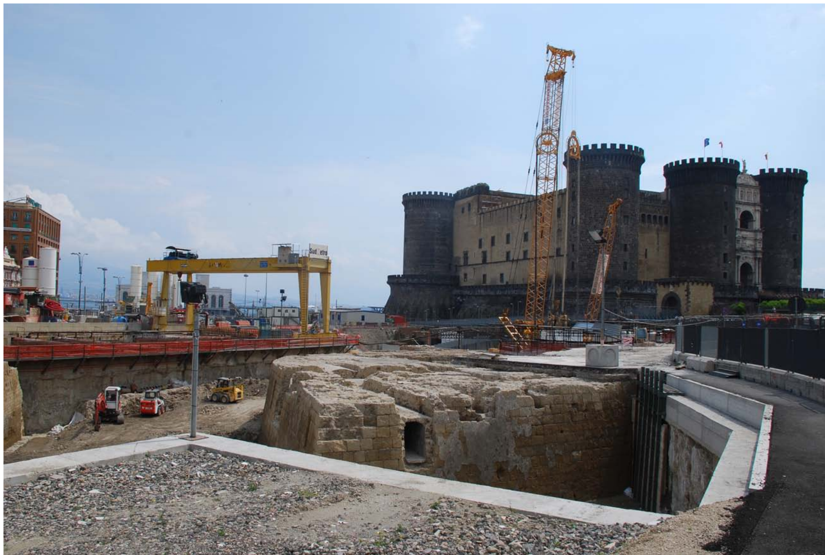
Fig. 1: Il cantiere della Linea 1 della Metropolitana di Napoli a Piazza Municipio. Lo scavo mostra la stratificazione del sottosuolo: la 'città per layer'.
