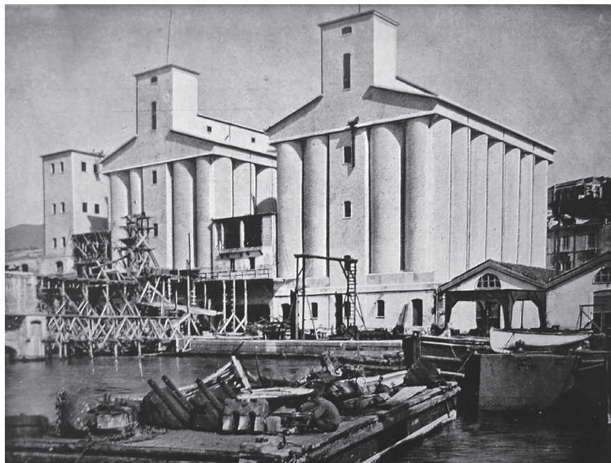
10. Castellammare di Stabia (Napoli), Silos granari, 1923 (da «Giornale dei Lavori Pubblici e delle strade ferrate», n. 20, 1924, p. 481).
