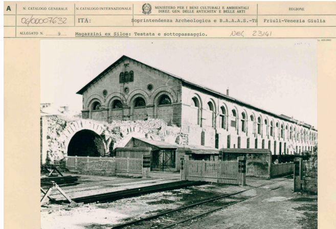
7. Trieste. "Magazzini ex Silos" progettati per il porto di Trieste dagli ingegneri Paulin Talabot e M. H. Pascal tra il 1861 e il 1865 (da https://catalogo.beniculturali.it/detail/ArchitetturaOrLandscapeHeritage/0600007632 , ultima consultazione: 14 luglio 2023).
