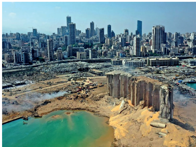
1. Beirut (Libano). I resti del silo granario dopo l'esplosione che ha investito il porto il 4 agosto 2020 ( https://www.icomos.org/en/get-involved/inform-us/heritage-alert/current-alerts/108048-icomos-heritage-alert-beirut-grain-silos ).
