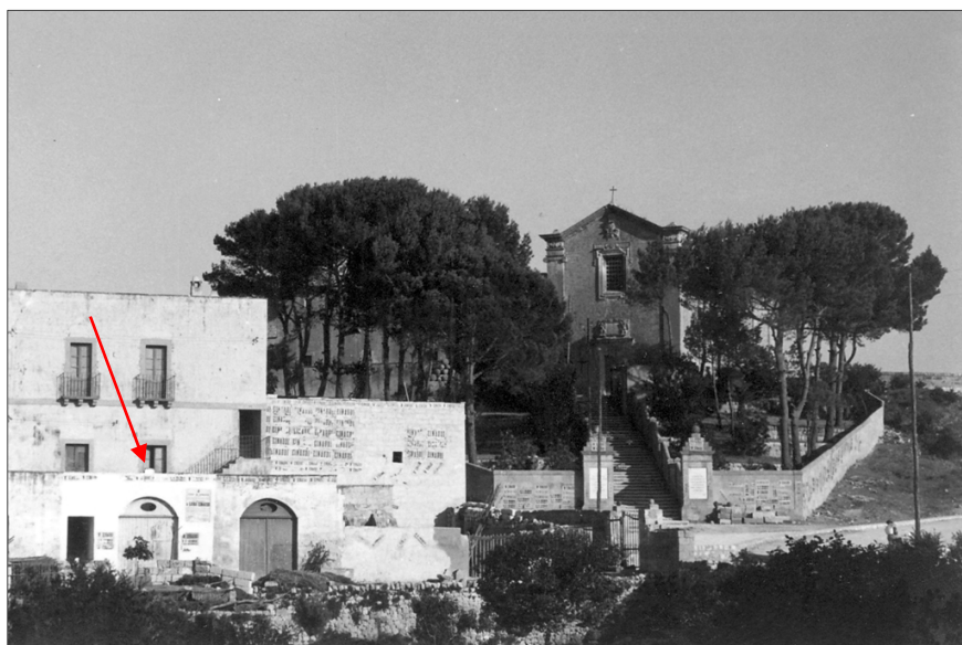
Fig. 4 – Otranto, la palazzina De Giuseppe alle pendici del Colle della Minerva in una foto del 1948 circa; sullo sfondo la chiesa di S. Maria dei Martiri. Sul parapetto del terrazzo al I piano è ben visibile, fuori asse, l'epigrafe di Glyka. A piano terra vi sono le due "limese" con entrata ad arco, nel corso della cui costruzione venne in luce l'epigrafe (foto: Archivio Dino Longo, Otranto).
