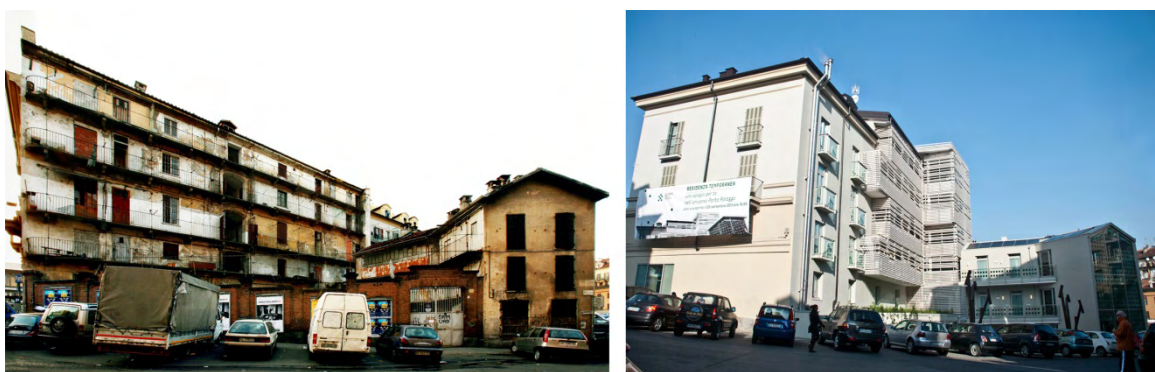
Fig. 1 The building in piazza della Repubblica – Porta Palazzo: before and after
