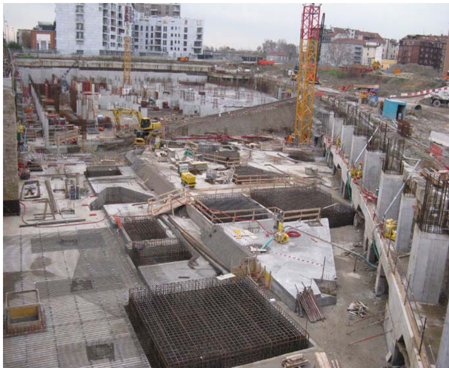
Lo stato di avanzamento dei lavori (novembre 2010).
