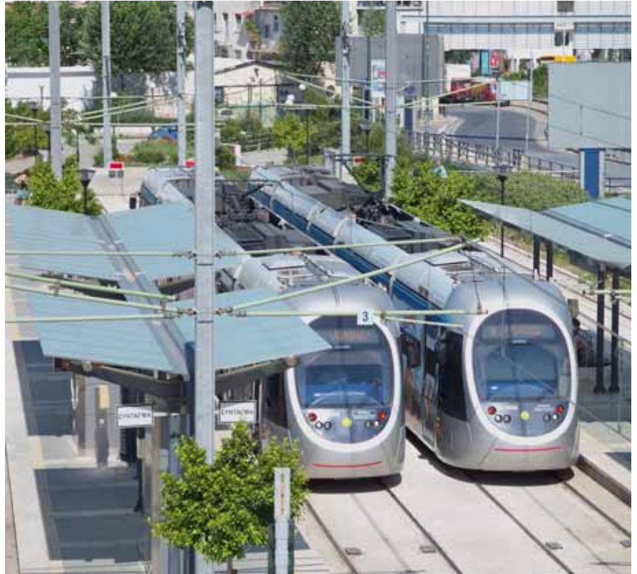
Tra i notevoli interventi effettuati ad Atene per le Olimpiadi del 2004 sulla rete su ferro vi è stata anche la realizzazione di una linea tramviaria lunga oltre 24 km.
