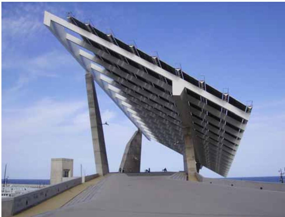
La grande cella fotovoltaica è una struttura di 10.500 m<sup>2</sup> realizzata lungo la costa all'interno della grande spianata del Forum. Costruita come contributo del Forum alla protezione dell'ambiente, la cella produce energia pulita e permette una riduzione di emissioni di gas serra.
