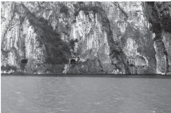
Figura 7 – Nell'orrido strapiombo della roccia calcarea sulle acque dell'Alto Benaco sembra irreali la presenza delle gallerie della Gardesana Occidentale.
