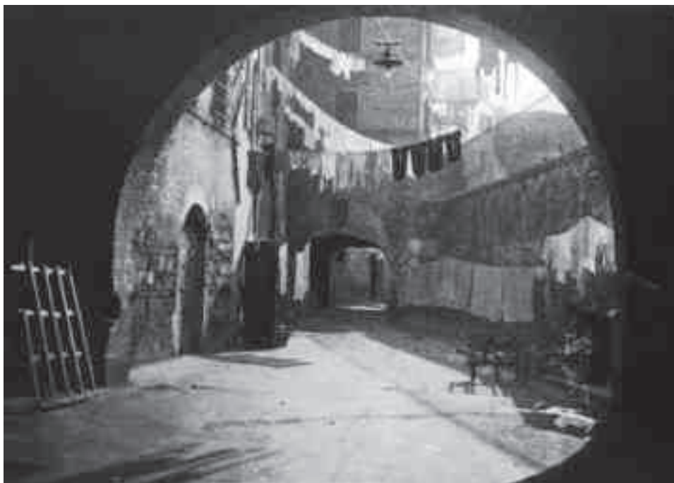
Ancona, volto di Via Sottomare che collegava Piazza San Primiano con la Dogana. La via correva a ridosso delle mura portuali, dalle cui portelle, talvolta, penetrava il mare in burnasca (collezione privata)
