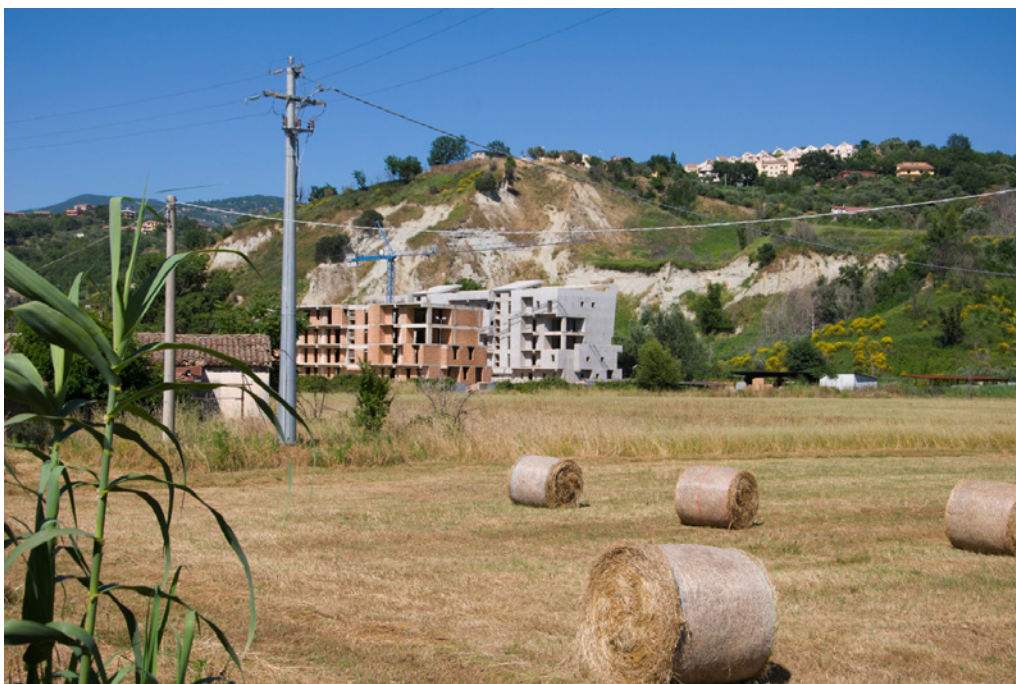
Fig. 2 - Margine nord Cosenza-Rende, zona industriale. Complesso residenziale in costruzione in aperta campagna
